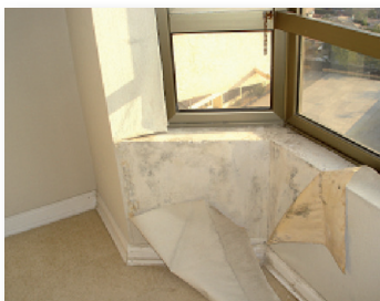
Fig. 1 Papel mural con hongos debido a condensación y mala ventilación
