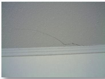
Fig. 2 Fisura en cielos (No presenta peligro para los habitantes)
