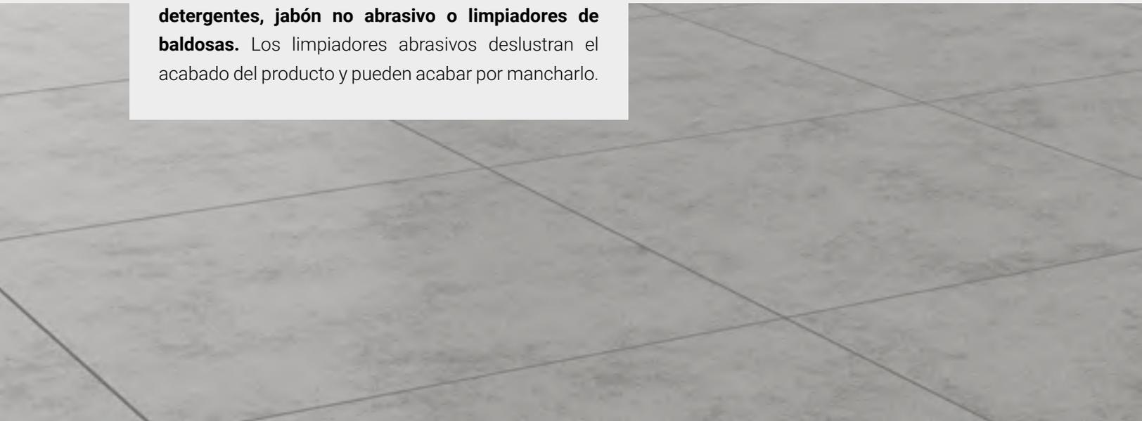
Dada la condición de los recintos donde se utilizan las cerámicas, es altamente probable la formación de hongos por lo que se recomienda su **mantención periódica**, revisar y cambiar el fragüe cuando este se haya quebrado o deteriorado y esté permitiendo el paso de agua a muros, pisos y tabiques.
